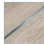
8 mm szélességű alumínium profil az ajtólapba süllyesztve
